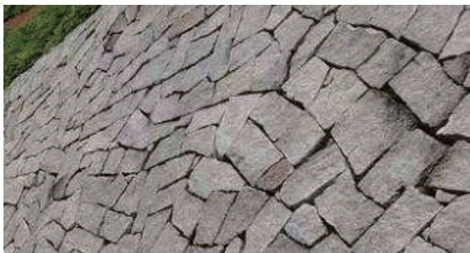
1.4 勾缝砂浆在砌体完成不久即脱落。
