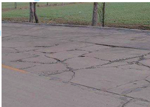
混凝土板块裂缝
