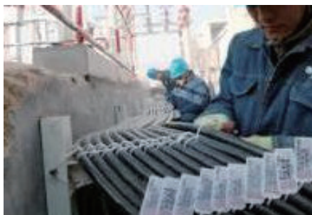
图 21-41 电缆沟支架、竖井支架电缆固定
