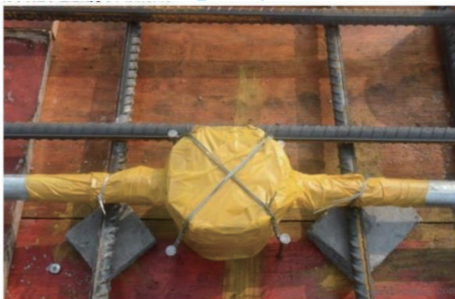
图 21-35 接线盒、管口封闭固定
