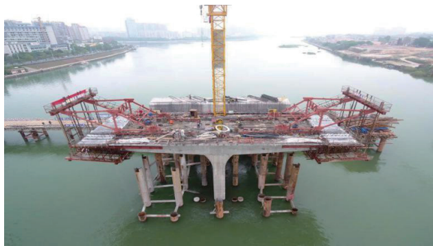
0# 段两侧安装挂篮的起始节段（起步段）线形偏差过大
