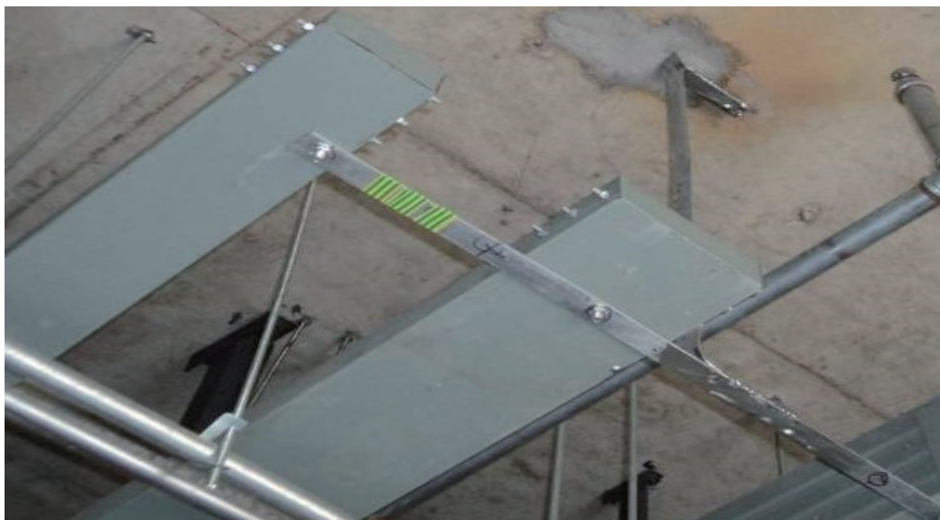
图 21-15 槽盒终端与接地干线连接
