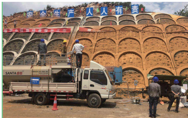
图 9.5.1 喷播绿化施工
