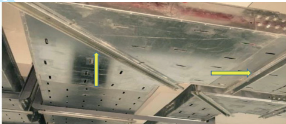
图 21-13 分支、转弯处、弯曲半径大弯通中部增设固定支架
