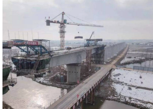
中跨合拢段施工线形偏差过大
