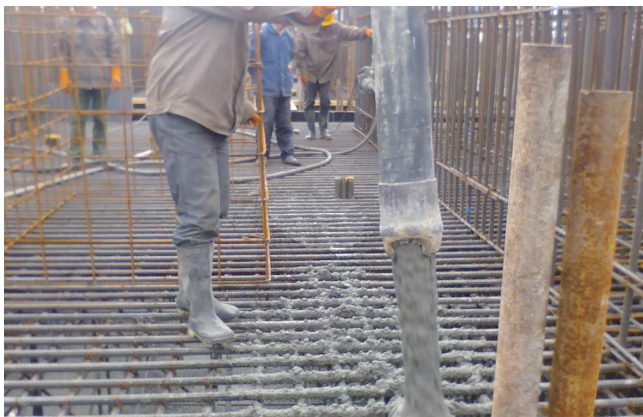
图 14-8 混凝土分层浇筑
