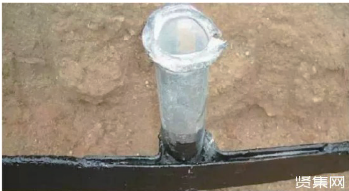
图 21-57 防雷接地扁铁搭接
