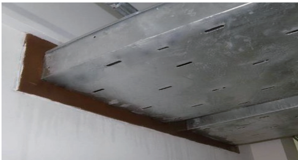
图 21-19 穿越防火分区隔墙的防火封堵
