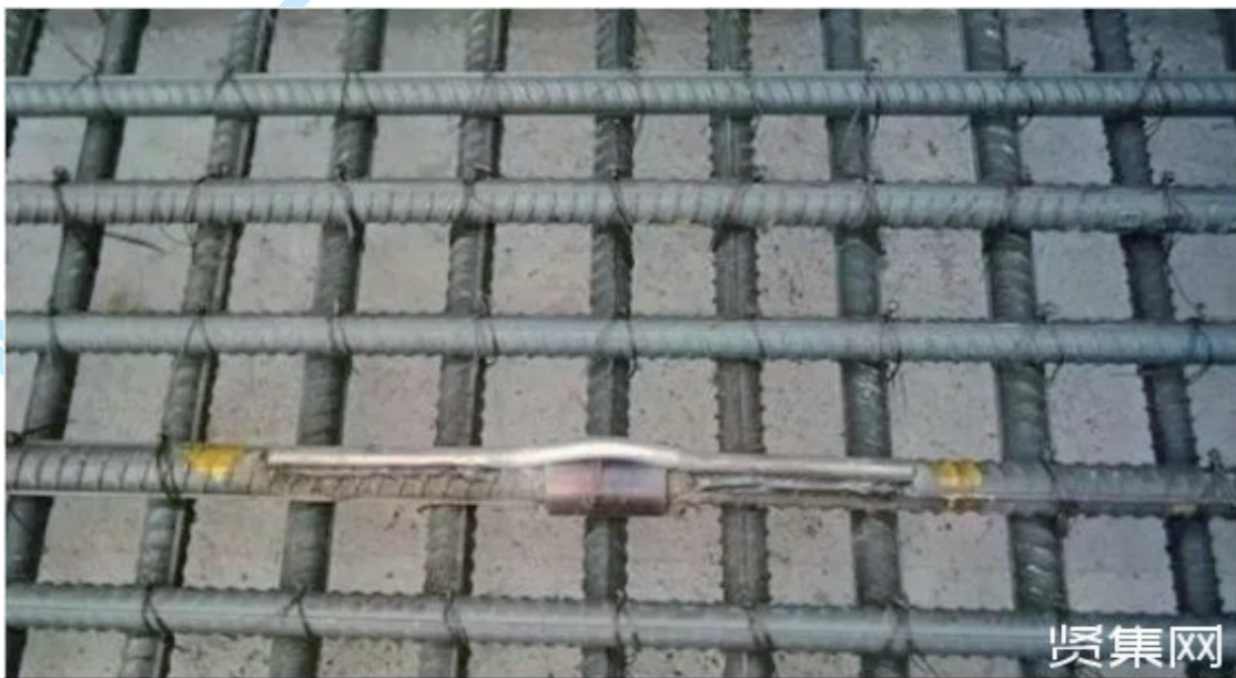
图 21-58 利用底板钢筋网作接地连接线
