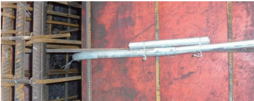
图 21-36 梁柱附近管接头强化保护
