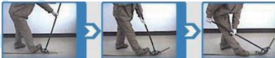
图 21-22 电线管（JDG 管）人力制弯
