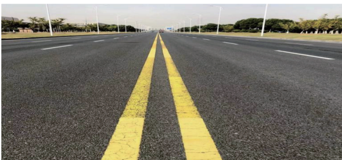
图 8.6.7-1 标线裂纹
