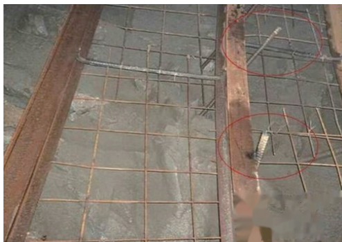
锚杆数量、长度不够，类型不符合设计要求，锚杆垫板未施作，拉拔力不足
