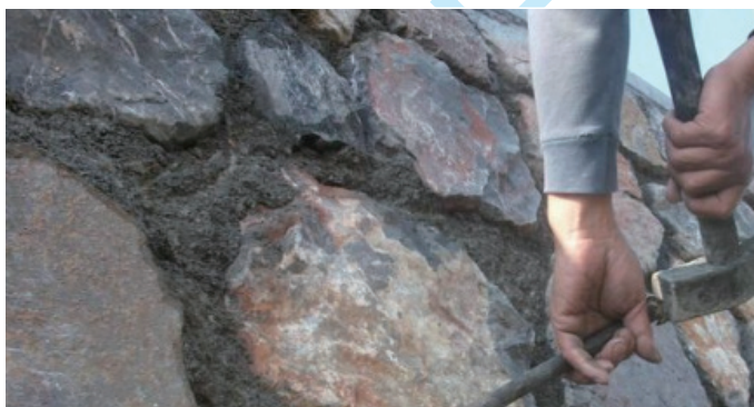
1.4 勾缝砂浆在砌体完成不久即脱落。
