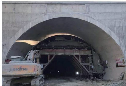
隧道洞口外观质量差，错台明显
