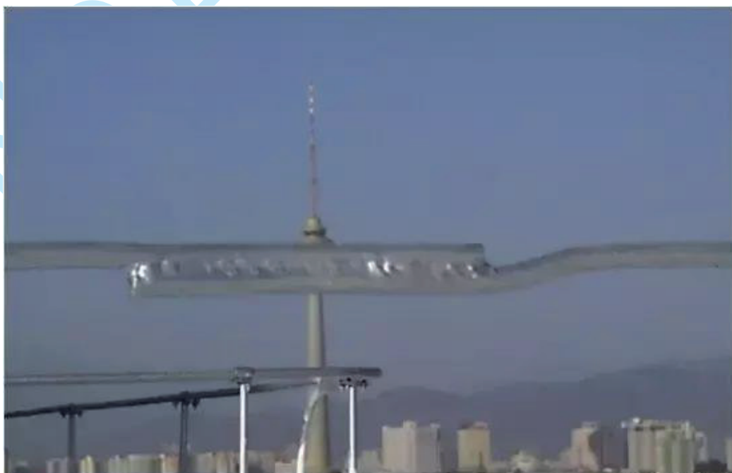
图 21-62 接闪器采用热镀锌圆钢时的搭接
