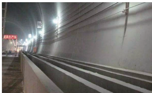
水沟电缆沟外观质量差，线型不顺直，排水沟排水不畅
