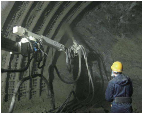
喷射混凝土厚度不足，局部中空，强度达不到设计要求，喷射回弹量大
