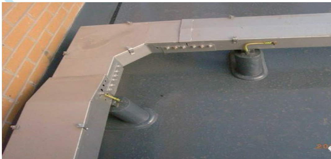
图 21-16 中间与接地干线可靠连接
