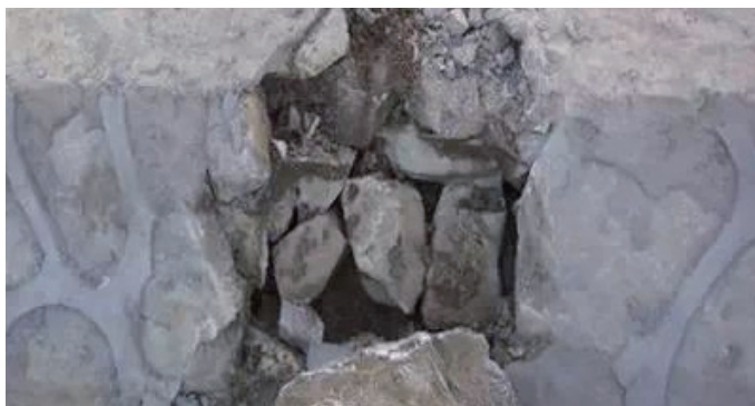
1.3 浆砌石大面凹凸不平，垂直度超出设计及规范标准，局部面石本身不平。
