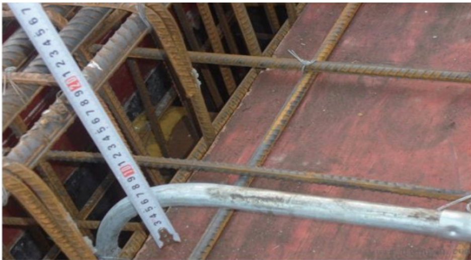
图 21-33 导管不得紧贴模板
