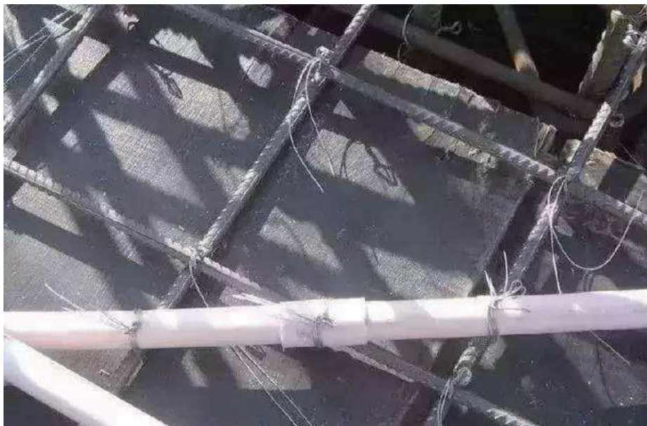
图 21-34 PVC 管管接头及两端与钢筋绑扎固定
