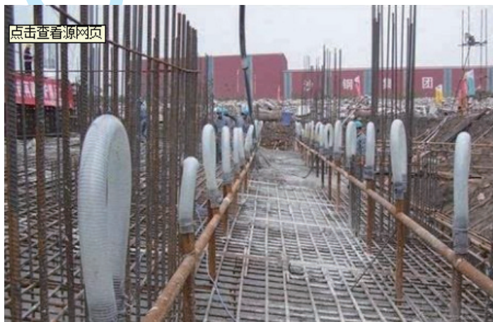
图 14-9 冷却水管安装
