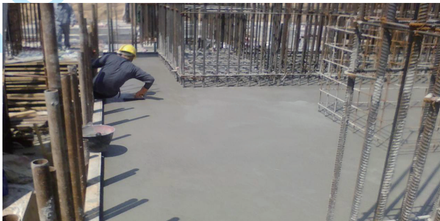
图 14-10 混凝土多次抹压收面
