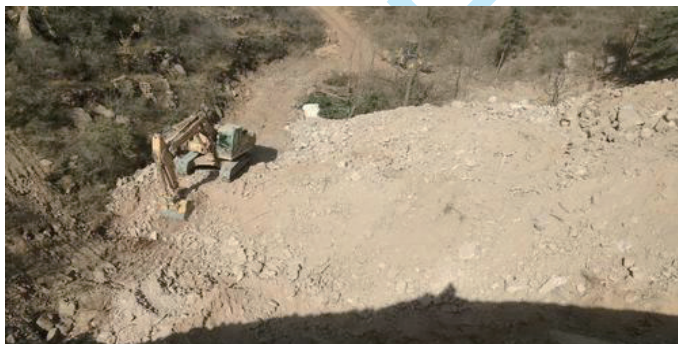
填挖结合处平整度差
