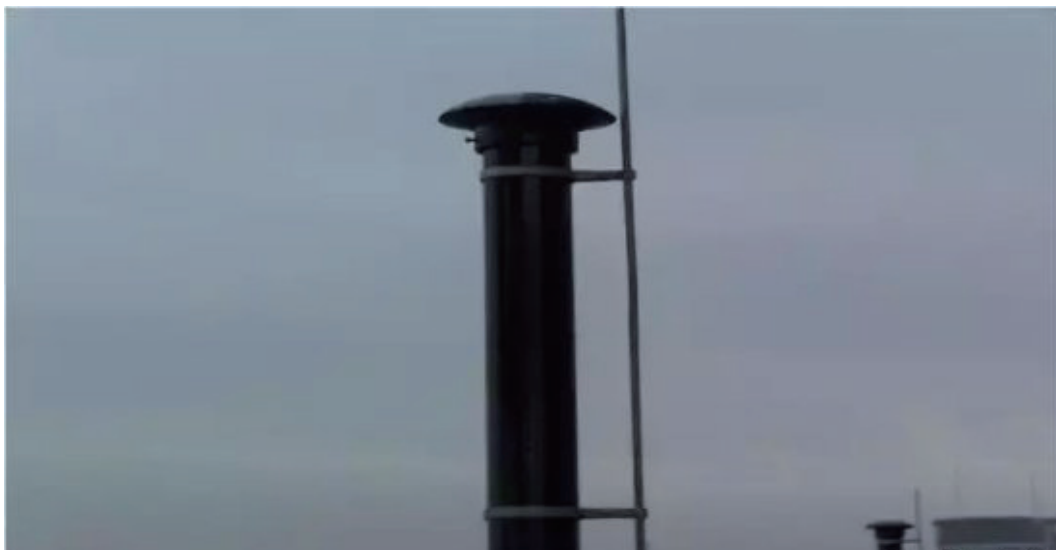
图 21-65 筑物屋顶上有突出物与避雷网焊接
