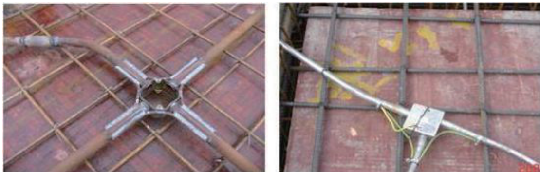
图 21-30 接线盒钢导管接地跨接
