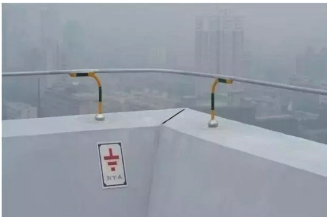
图 21-67 避雷线安装
