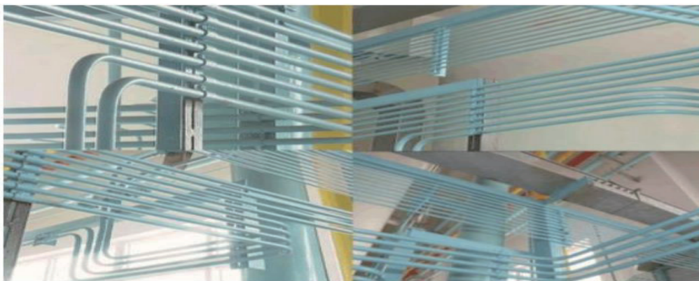
图 21-37 成排钢管导管排列整齐
