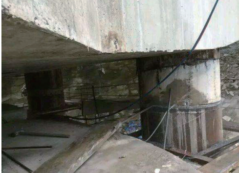
墩顶梁段（0# 段）临时固结不牢
