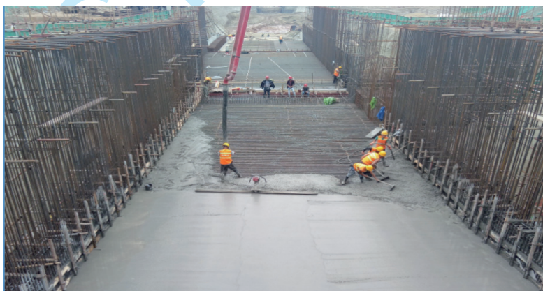
图 11.3.1 管廊混凝土浇筑
