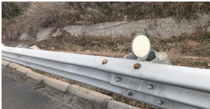
图 8.6.1-1 交安设施螺栓锈蚀
