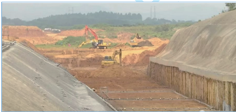
图 11.2.1 管廊基坑开挖及支护
