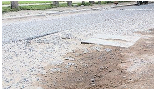
混凝土板面出现死坑
