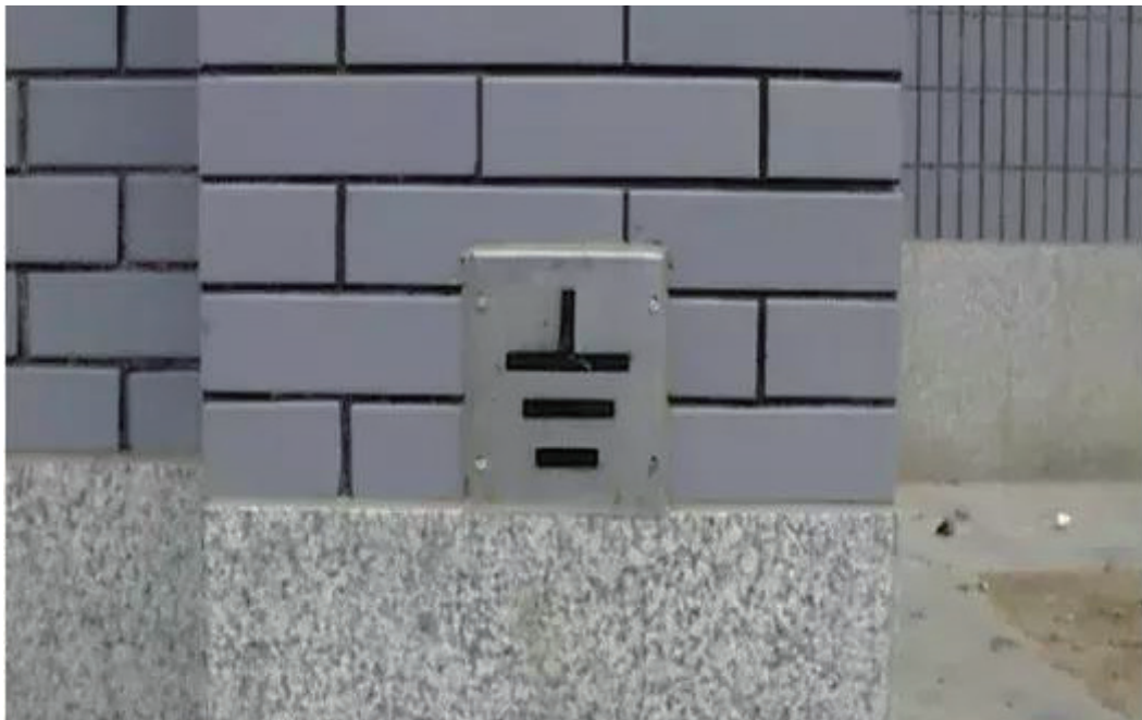
图 21-63 暗装测试点
