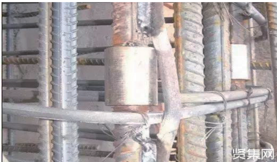
图 21-59 防雷接地引下线焊接
