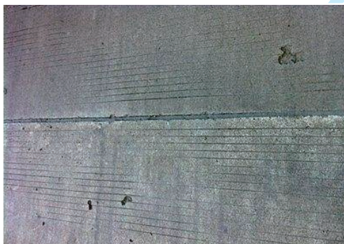
胀缝处破损
