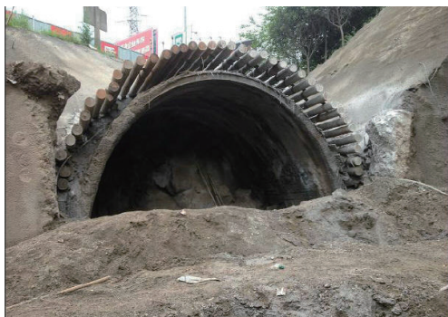
管棚底部侵入开挖轮廓线、管棚装入长度不够、钢管连接质量差
