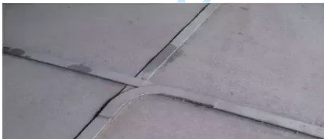
图 21-60 防雷接地扁铁敷设
