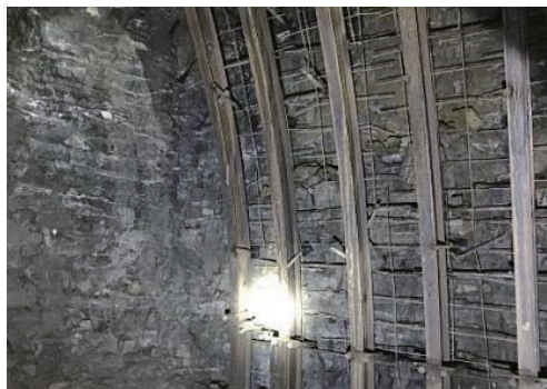
拱架加工几何尺寸不规范，钢架连接板连接不牢，架立间距过大
