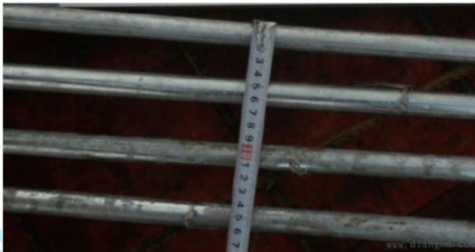
图 21-32 成排暗配导管保证管间距离
