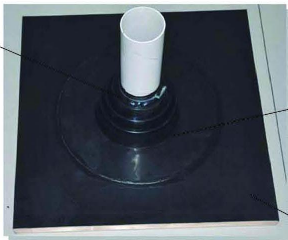
管道穿屋面套管安装图
